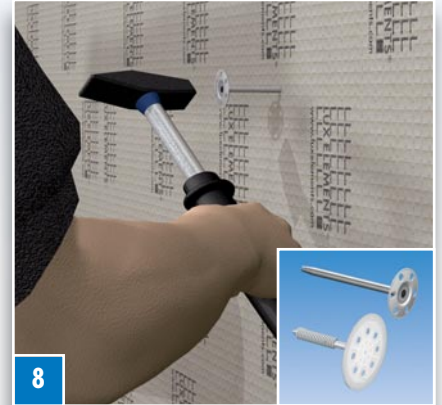
8 ... mit FIX-FID oder FIX-KSD dübeln. Vorsicht wegen Wasser- und Stromleitungen!
