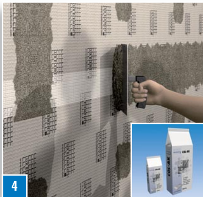
4 Die armierten Elementstöße sowie die Köpfe der Schlagdübel mit COL-AK absputteln.
