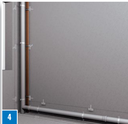
4 MONT-UNI an den angezeichneten Positionen ausrichten.
