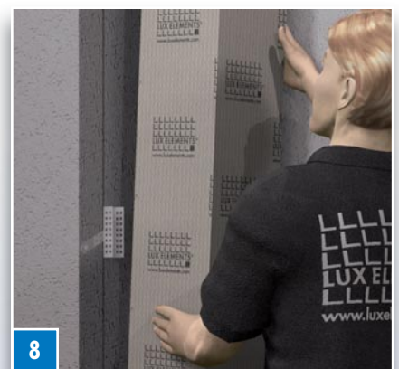
8 TEC Rohrverkleidung lotrecht ausrichten und an die Wand andrücken.
